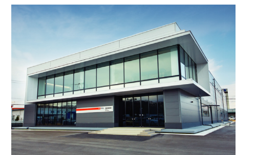
新開発センター New R&D Center
